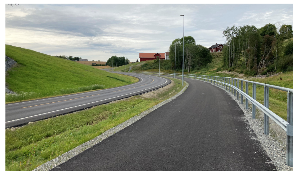
Ny gang- og sykkelvei på fylkesvei 169 mellom Fjellsrud og Stensrud gjør det mulig for flere elever å sykle til Dalen skole
