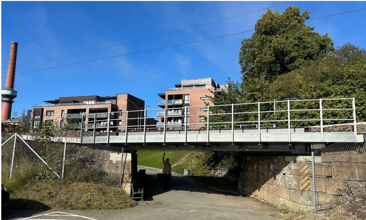
Figur 4-5 Eksempel på en relativt bred jernbaneundergang med lav overbygging. Fra Dovrebanen på Hamar.
