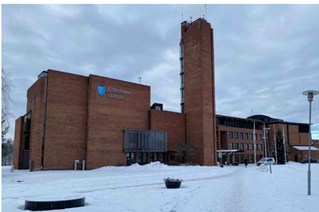
Rådhuset, bygget i 1988-90, Bergersen Gromholt og Ottar arkitekter AS og Arne Takla Arkitekter.
