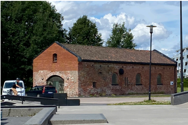
Dampmaskinhallen fra 1860. Brandsvalsaga var den første dampdrevne sagen langs Nitelva.
