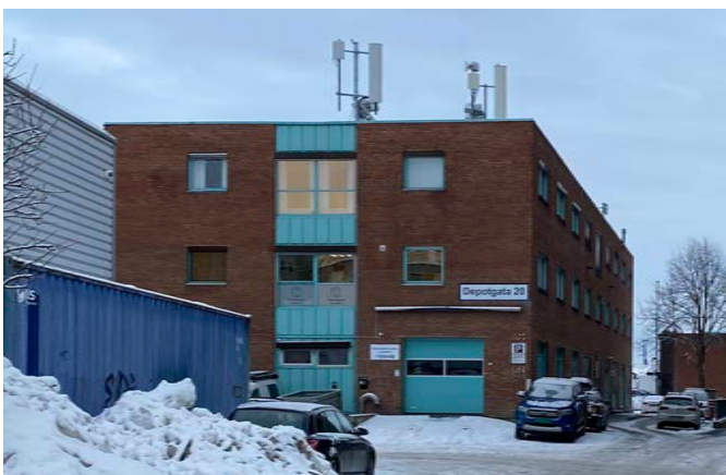
Depotgata 20, kommunale kontorer for helsetjenester, bygget i 1987-89.
