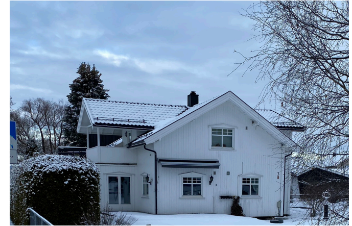
Strandpromenaden 3, en Sefrak registrert bolig, antatt bygget rundt 1880.
