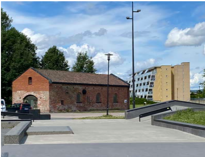
Foto midt i planområdet ved skateparken, her ses dampmaskinbygget og en nyere boligblokk.
