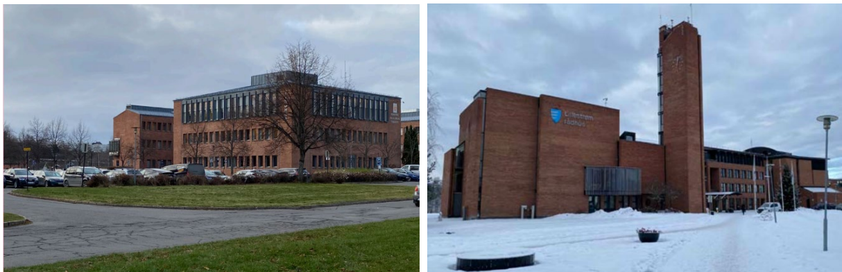
Figur 7 Justisbyggene til venstre og rådhuset til høyre. Foto: Lillestrøm kommune.
