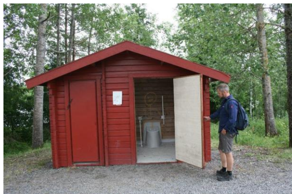
Utedo med tett tank ved badeområdet, Heianebben.
