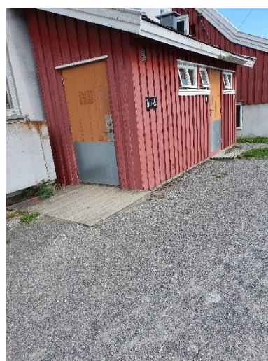
Toalett på oversiden av kaféen.
