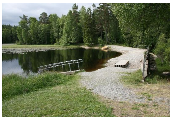
Rullestolrampe ved damanlegg. Gode muligheter for å kunne gå videre inn til bl.a. skistadion. Anlegget er ikke godkjent etter standard for universell utforming.
