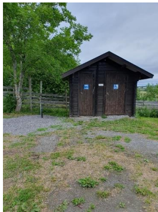
Toalett som er universell utformet. Vannkran utenfor til venstre (sommervann)
