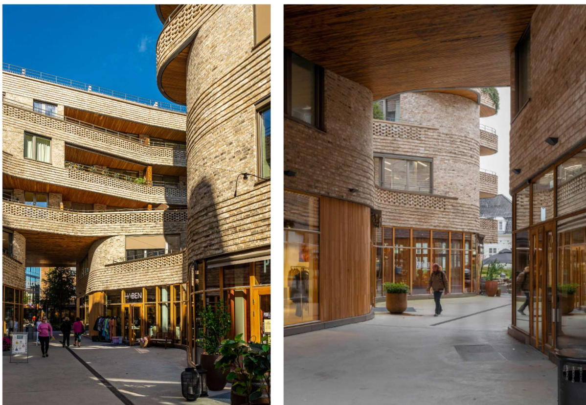
Figur 41. Wesselkvartalet i Asker. Gangpassasjer gjennom bebyggelsen kobler byrommene sammen. Bygningsvolumene er tilpasset i form og høyde for å slippe mest mulig lys inn i kvartalet. Arkitekt: Vignæs Kosberg Arkitekter. Foto: Nils Petter Dale + Magnus Aamand Lindquist.
