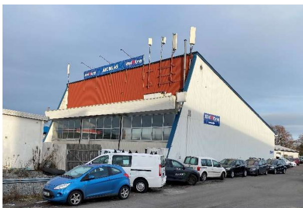
Figur 25. Bussgarasjen i Depotgata 10 Foto: Lillestrøm kommune
