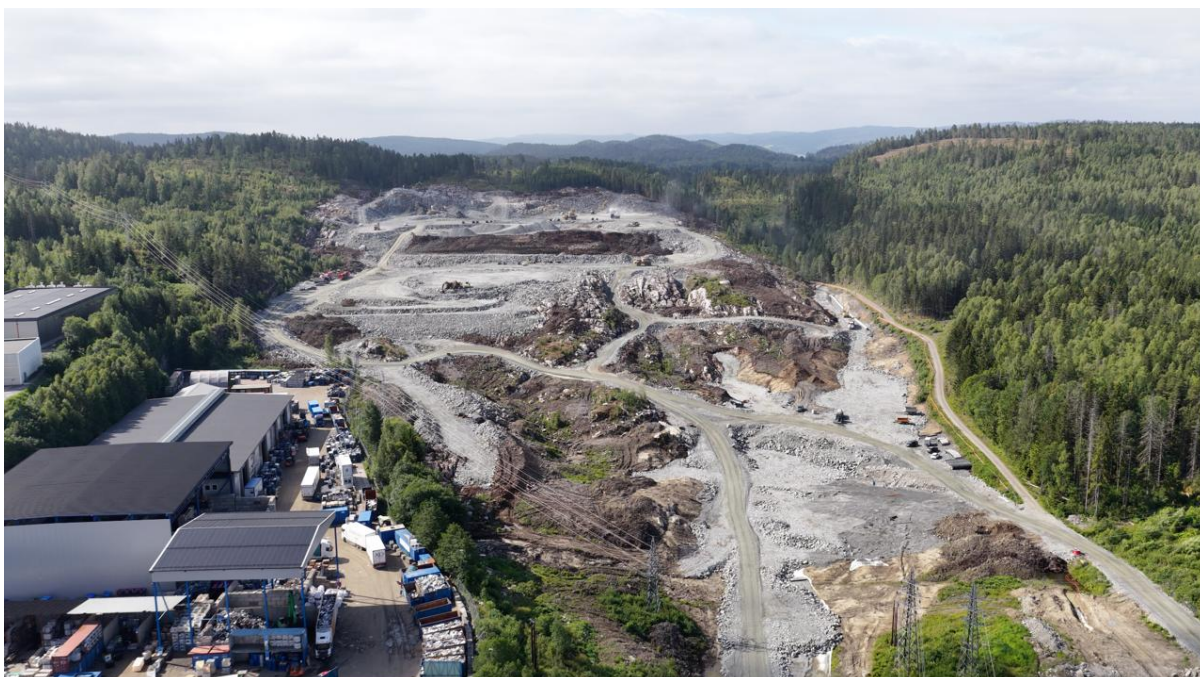
Figur 3: Foto av dagens situasjon som viser pågående tomteopparbeidelse (juni 2025).
