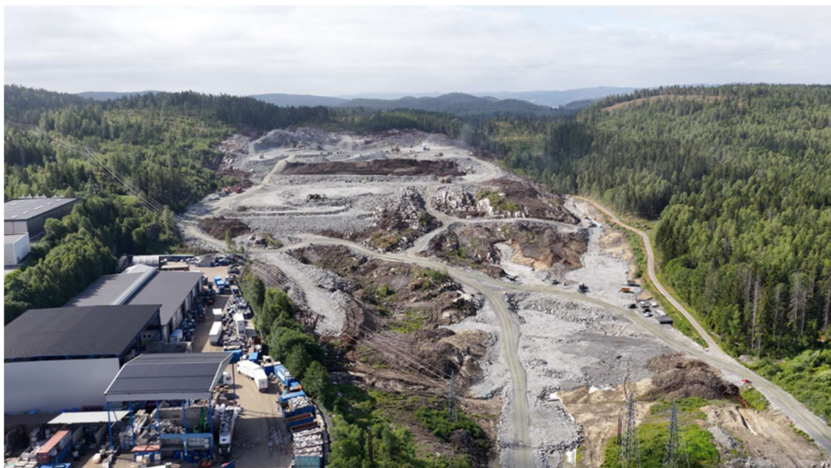
Figur 4: Figuren viser foto av dagens situasjon som viser pågående tomteopparbeidelse (juni 2025).
