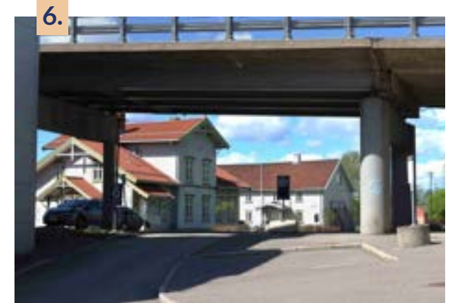
Undergangen under Rælingsbrua
