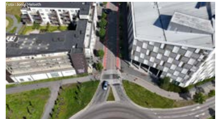
Kanalveien ved rundkjøringen på Rv159
