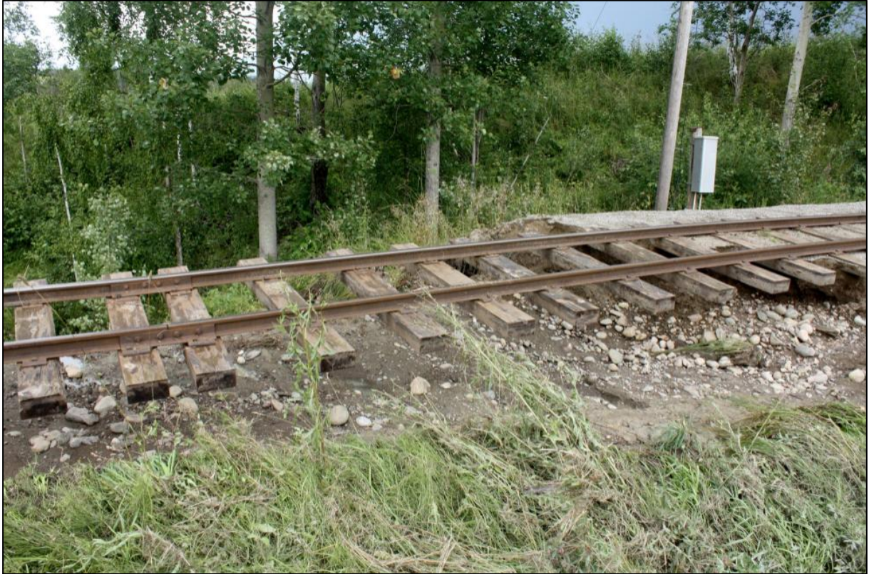
Figur 13. Skader på Urskog-Hølandsbanen etter styrtregn 12. juli 2016. Foto: Espen Børrestuen, Romerikes Blad.
