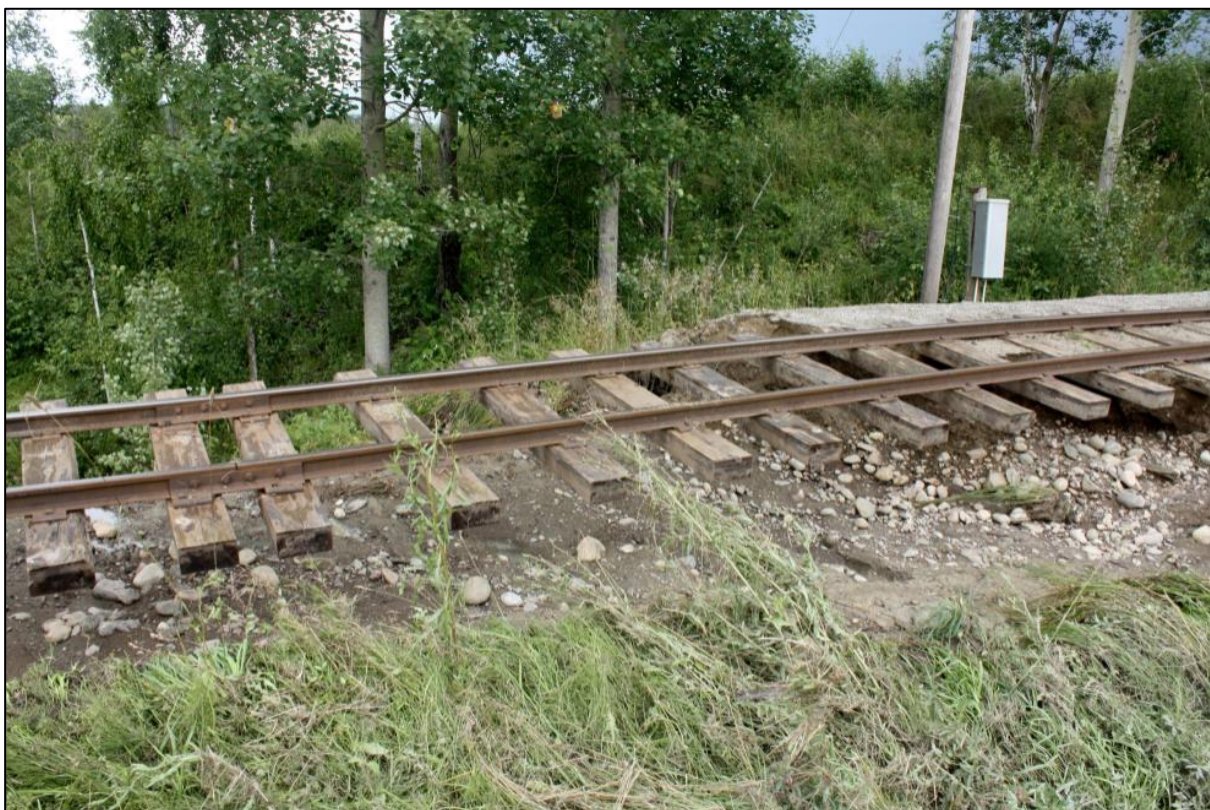
Figur 15. Skader på Urskog-Hølandsbanen etter styrtregn 12. juli 2016. Foto: Espen Børrestuen, Romerikes Blad.
