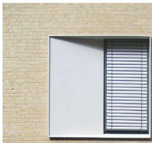
Eksempel metall i vindussmyg, Akutten Ullevål sykehus, Nordic officearchitecture
