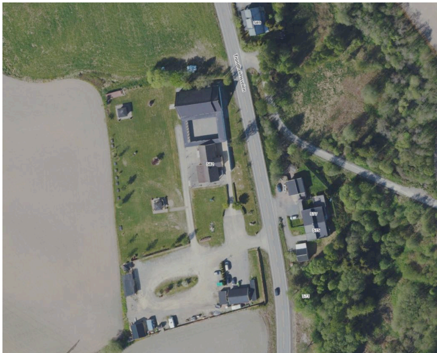
Flyfoto av planområdet med eksisterende tempel og munkebolig.
