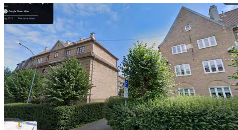
variasjon i bearbeiding fasade
