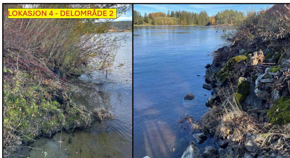
Figur 1.16: Overflateerosjon i vannkant (venstre), og mulig oppfylte masser (høyre). Lokasjon 4, delområde 2, iht. figur 1.12.
