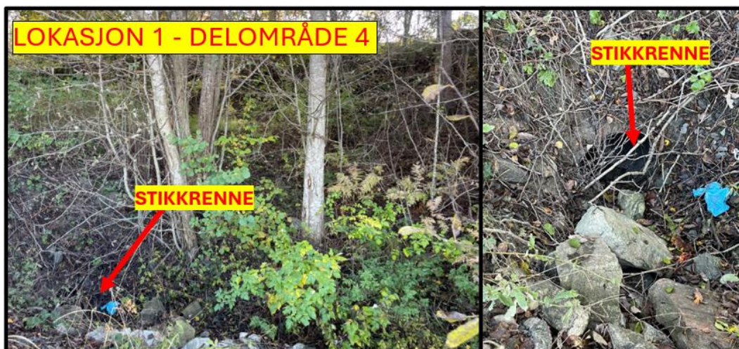
Figur 1.24: Stikkrenne sett fra nord, ikke vann. Lokasjon 1, delområde 4, iht. figur 1.23.
