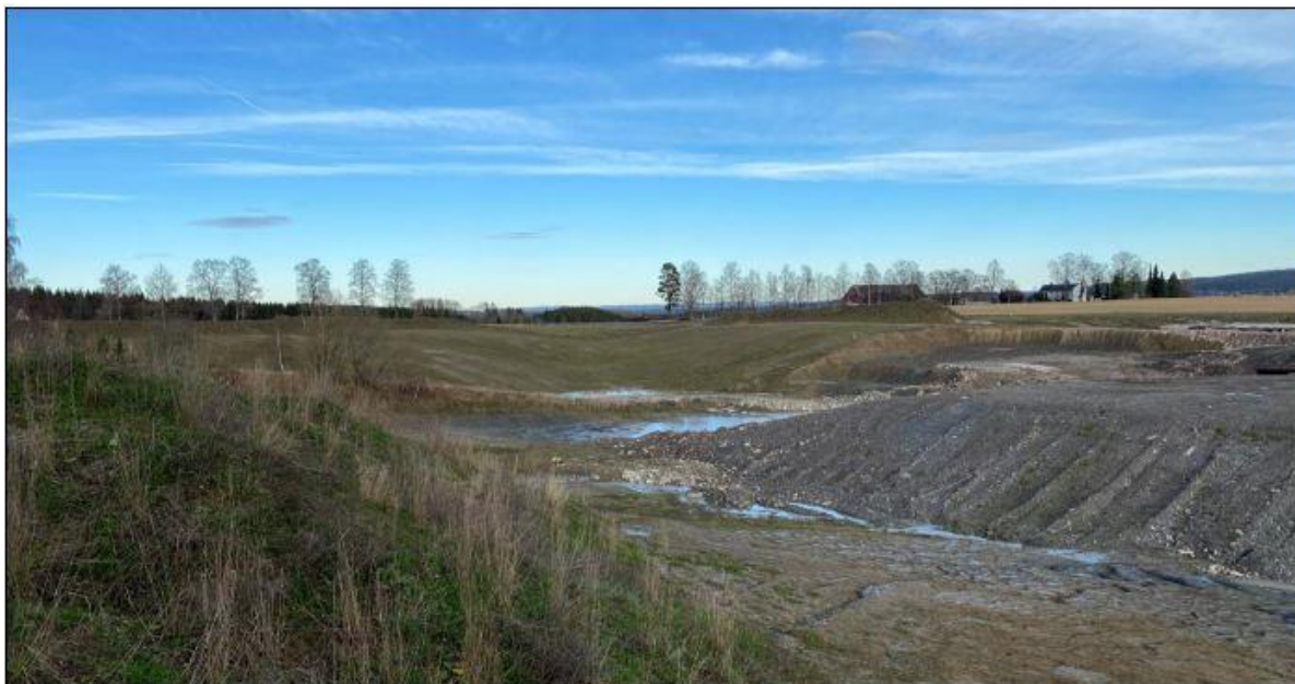
Figur 5.11: Daldraget stiger fra sør mot nord. Her sees Presterud nord i bildet og oppfyllingen som er i gang nede i den tidligere ravinen.
