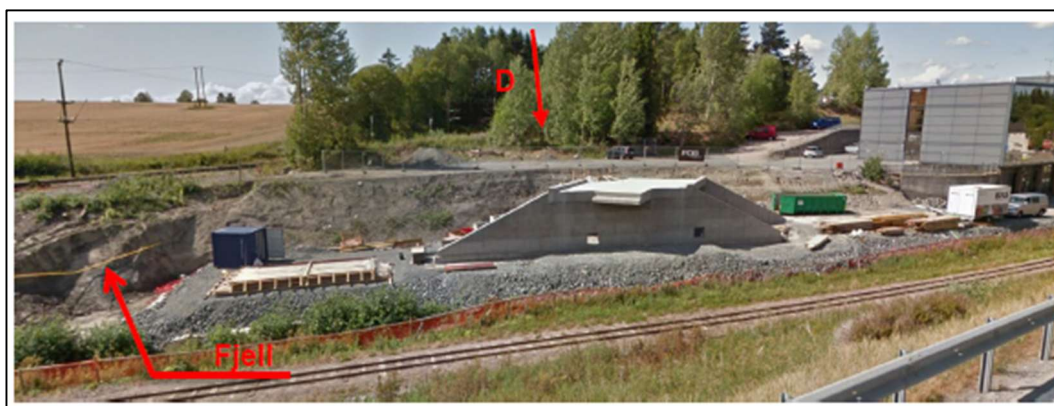
Bilde 3.4 Bilde tatt i nærheten av plassering av borpunkt C, stedlige løsmasser av sand og silt samt fjell til venstre på bilden. Grunnvann er ikke synlig.
