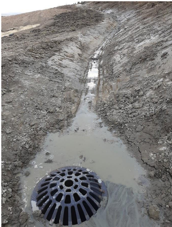
Figur 8: Avskjæringsgrøft (Foto: Anders Egner)
