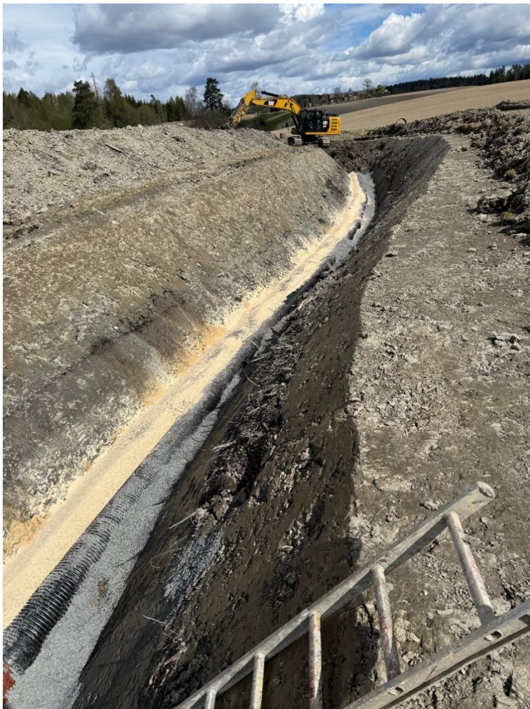
Figur 7: Utbedring av hydrotekniske anlegg (Foto: Anders Egner)
