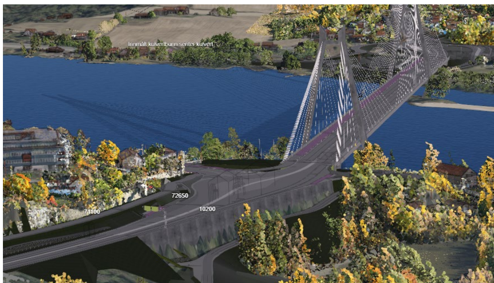
Rundkjøring og skråstagbru. 46 meter avstand til Sootbrakka.
