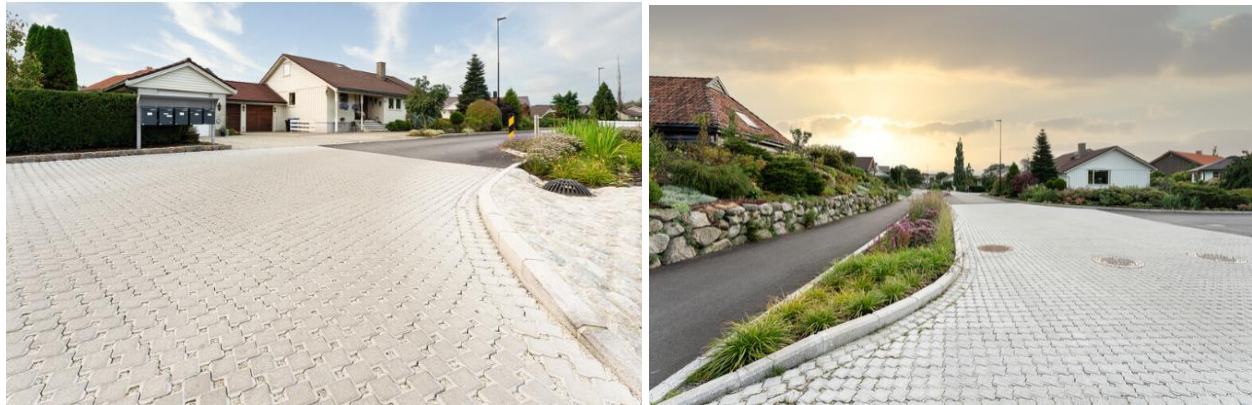
Figur 37. Permeabel belegning i et vegkryss på kommunal veg i Bryne (Skjeveland.no).
