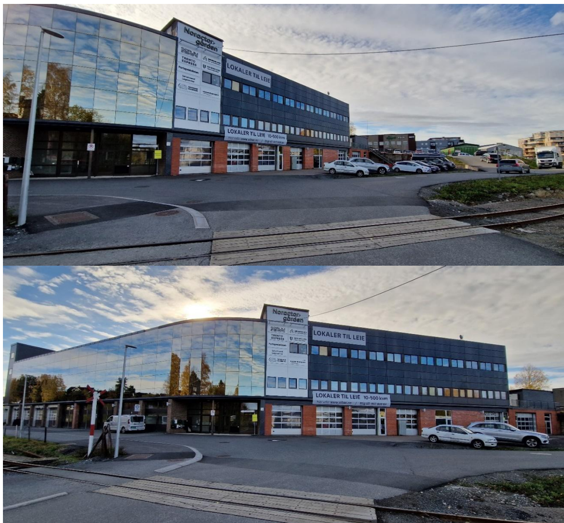
Figur 25 – Foto av eksisterende bygg ut mot Blakerveien. Det eksisterende næringsbygget beholdes, også kalt «Noractorgården»
