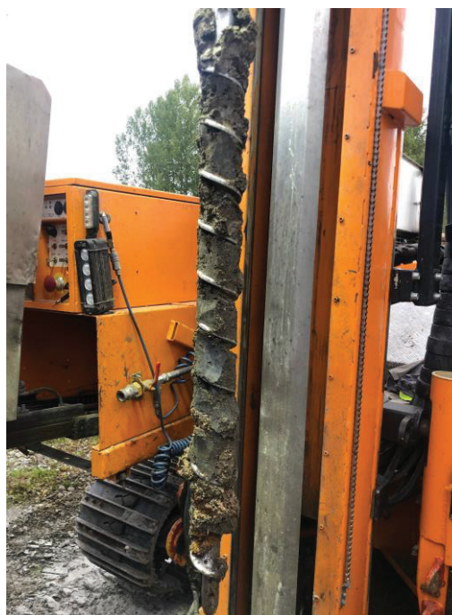
Bilde 3.6 Borpunkt C: Dybde 1-2 m. Leire/silt, rester av treverk.
