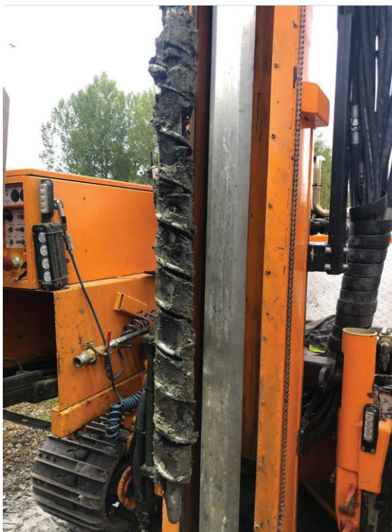
Bilde 3.9 Borpunkt C: Dybde 4-5 m. Steinlag fra 3,9-4,3 m dybde, leire/silt til 5 m.
