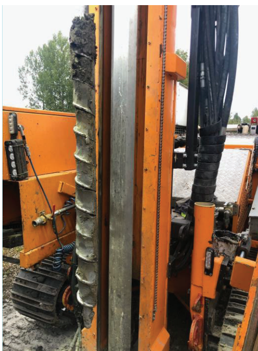
Bilde 3.7 Borpunkt C: Dybde 2-3 m. Leire/silt
