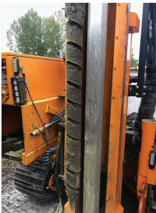
Bilde 3.5 Borpunkt C: Dybde 0-1 m. Fyllmasser, sand og grus.
