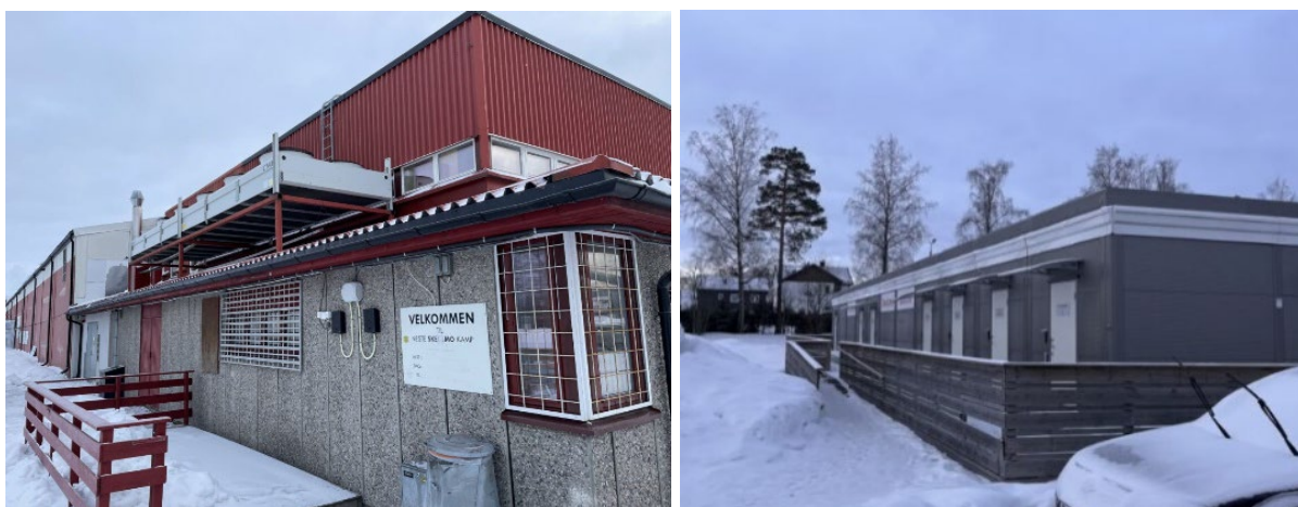
Figur 4-7: Skedsmo Ishall til venstre og garderobebygget til høyre. Foto: COWI.
