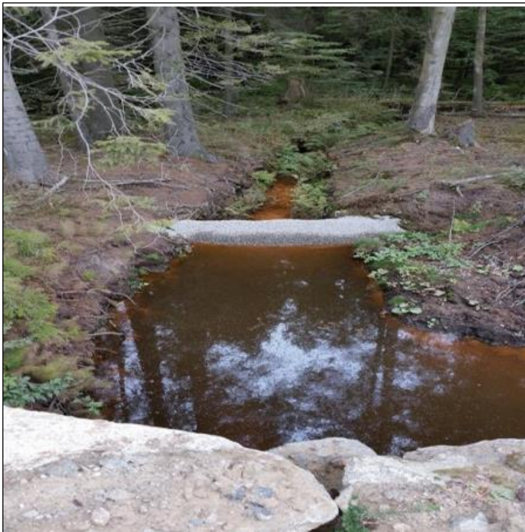
Figur 19. Eksempel på filtervoll og sedimentasjonsdam i bekkeløp nedstrøms skytebane (kilde: Asplan-Viak).
