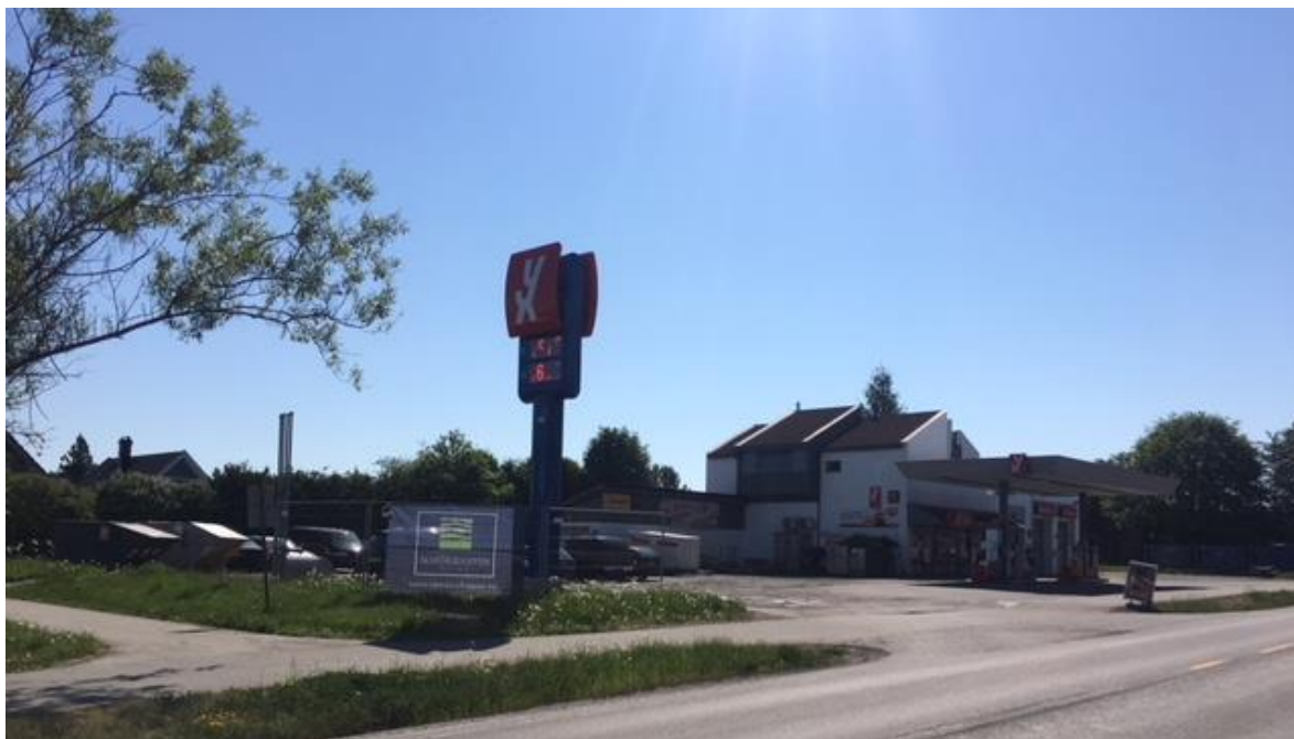
Figur 6 Eksisterende Hydro Texaco på Sørumsand
