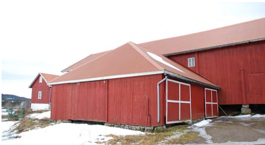
Maskinhuset på Tofsrud er et meget sjeldent og godt bevart kulturminne
