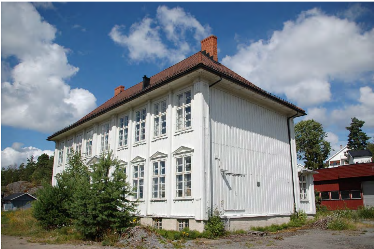
Dalen skole, ett av mange praktbygg i Fet som er tegnet av byggmester Axel Bjørnstad
