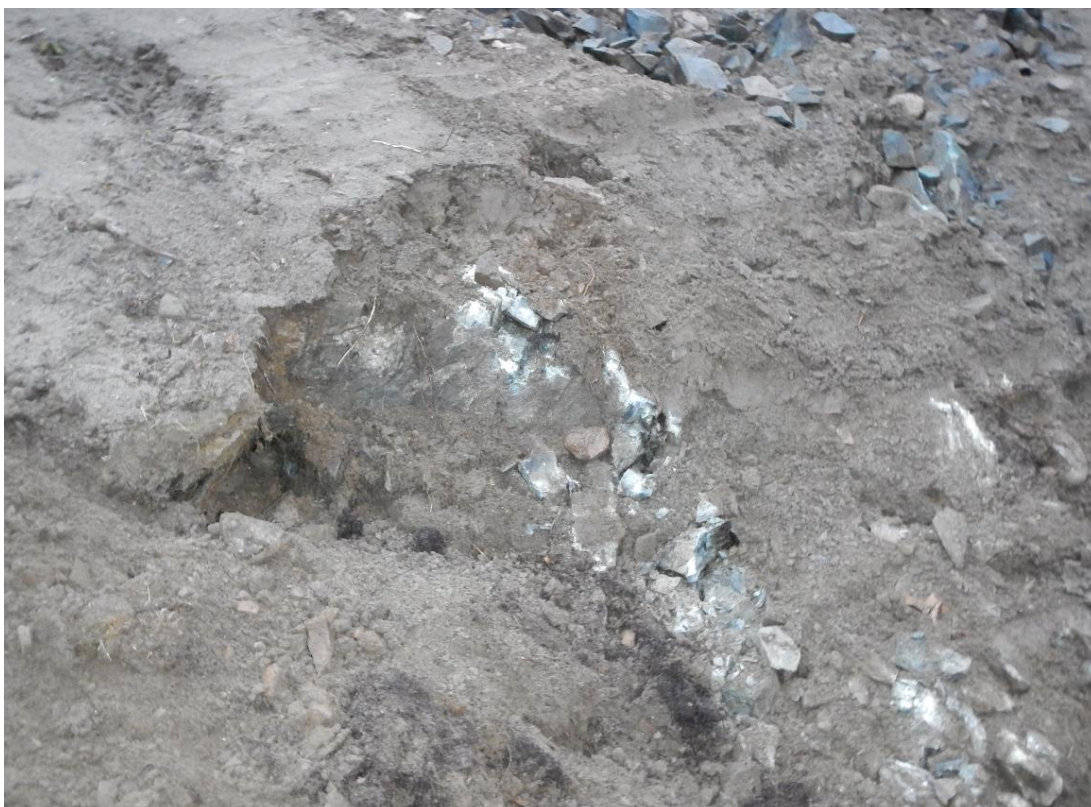
Bilde 14. Graving i masser under skytevollen. Under sanden ble det påtruffet skogsjord og forvitret stein.
