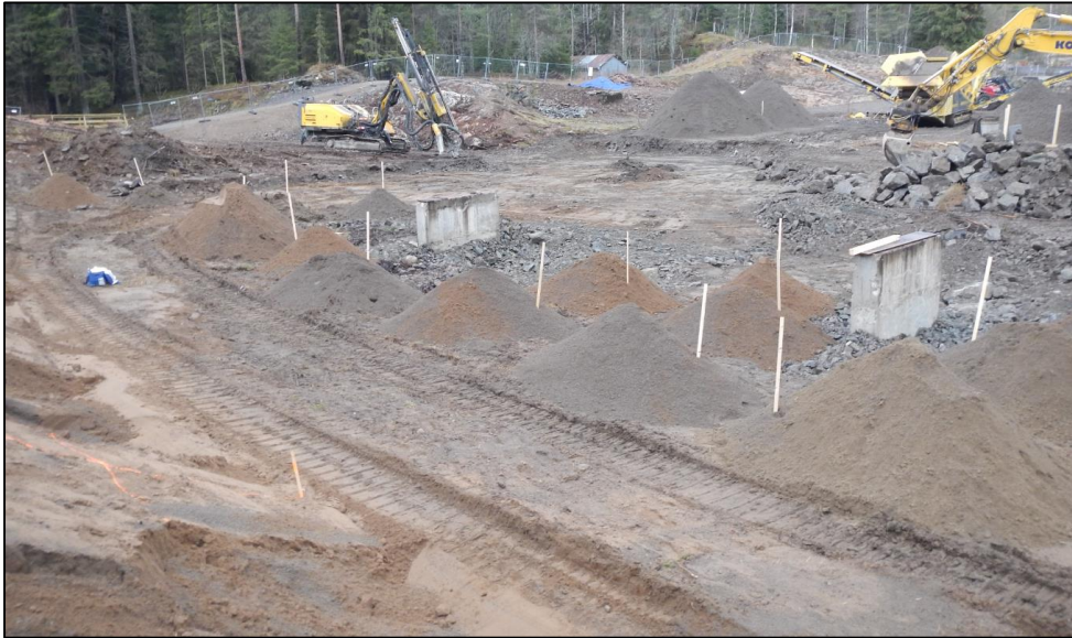
Bilde 5. Sortering av masser fra seksjoner i skytevoll iht. forurensningsgrad.
