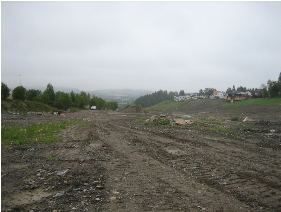
Planområdet sett fra sør mens oppfyllingen fortsatt pågikk.
