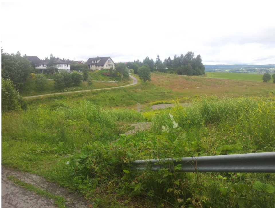
Bildet viser gang- og sykkelveien mellom Guldhaug/Tømte og Skjettenveien. Det har oppstått et tråkk/snarvei rett over dalen. Den gruslagte balløkken kan skimtes midt i bildet.
