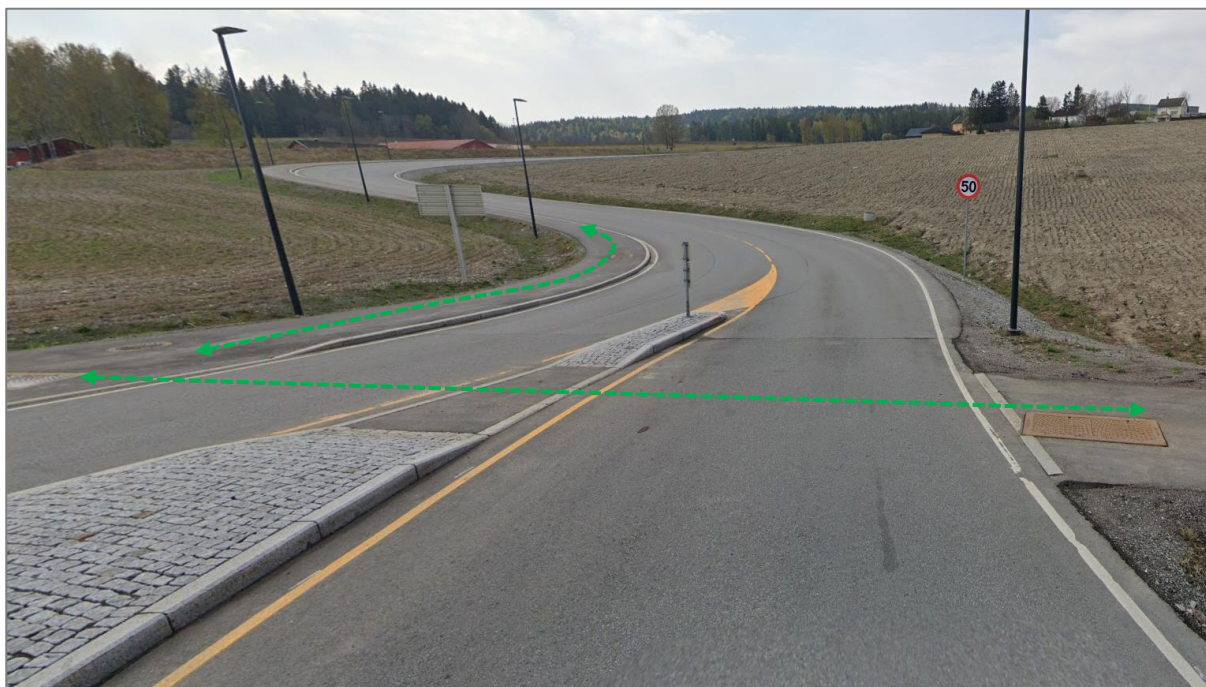
Figur 12: Lahaugmoveien ved krysset med fv.1530 Bråteveien, sett fra krysset, med fortau på sørsiden og tilrettelagt gangkryssing over Lahaugmoveien (kilde: Google maps)
