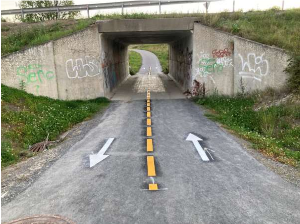
Figur 5 Ny midtlinje og retningspiler i undergang på Skjetten
