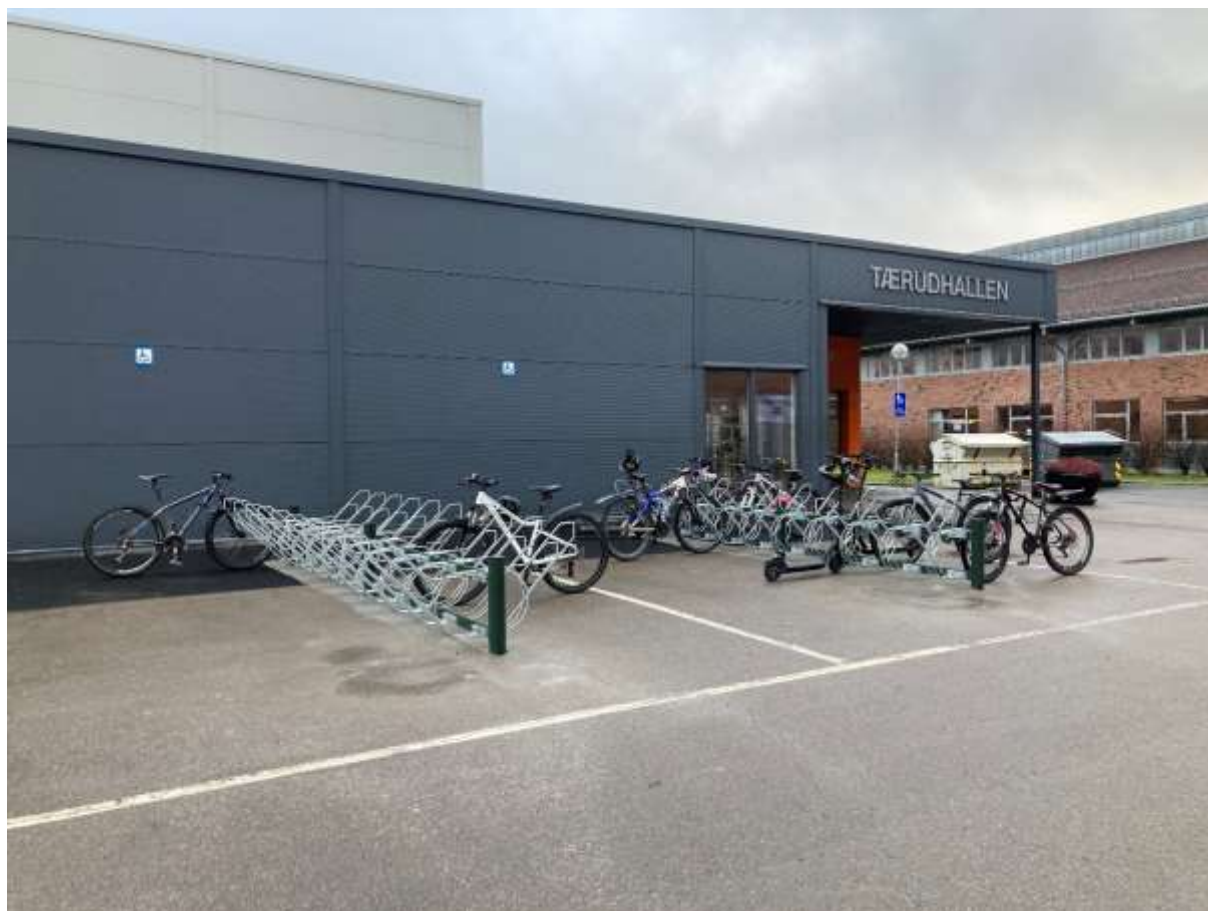
Figur 3 Nye sykkelstativ ved Tærudhallen
