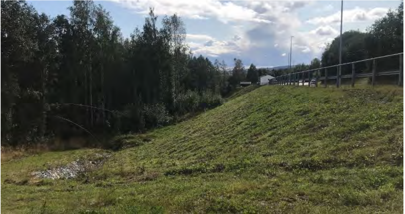
Figur 25 Langs Trondheimsveien vest for ravinedalen Huseby I er det nylig anlagt gang- og sykkelsti. Ravinedalens grenser er justert for å ekskludere partier påvirket av fyllmasser.
