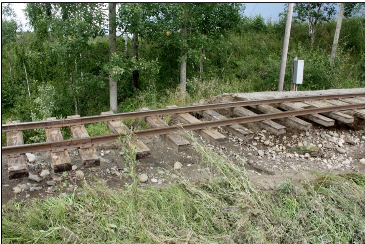
Figur 21. Skader på Urskog-Hølandsbanen etter styrtregn 12. juli 2016. Foto: Espen Børrestuen, Romerikes Blad.
