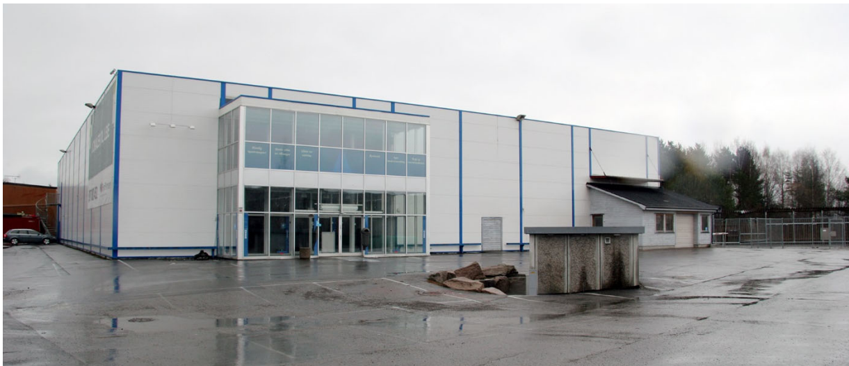
Figur 25: Eksisterende bygg på Skjærvaveien 44 - Maxbo-hallen. Pumpestasjonen ligger i forgrunnen.
